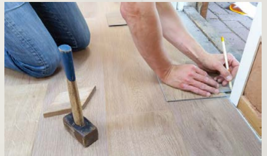
Instalaciones de pavimentos
